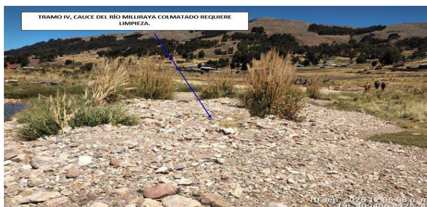
FIGURA N°03: TRAMO CRÍTICO IV, EN EL CAUCE DEL RÍO MILLIRAYA TOTALMENTE COLMATADO REQUIERE LIMPIEZA Y CONFORMACIÓN DE DIQUE CON MATERIAL PROPIO, AFECTADO LA CARRETERA DE ACCESO Y VIVIENDAS DE LA CC. MILLIRAYA, DISTRITO Y PROVINCIA DE HUANCANE, DEPARTAMENTO DE PUNO.
