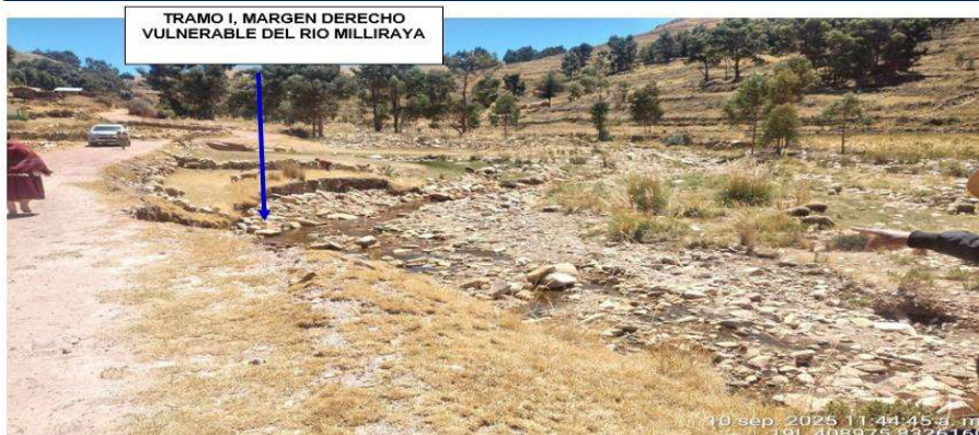
FIGURA N°01: TRAMO CRÍTICO I, EN EL MARGEN DERECHO DEL RÍO MILLIRAYA, AFECTADO LA CARRETERA DE ACCESO A C.C. MILLIRAYA DISTRITO Y PROVINCIA DE HUANCANÉ, DPTO PUNO.
