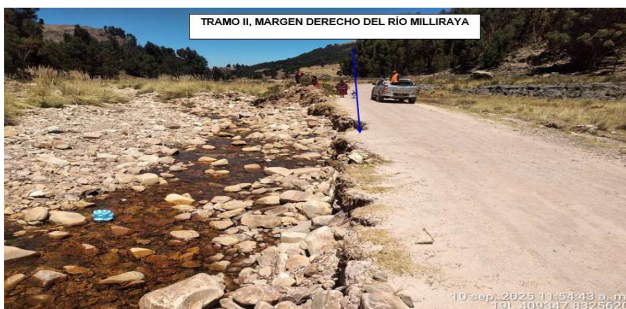
FIGURA N°02: TRAMO CRÍTICO II, EN EL MARGEN DERECHO DEL RÍO MILLIRAYA, POR EROSIÓN DEL AGUA ES AFECTADO LA CARRETERA DE ACCESO A LA COMUNIDAD MILLIRAYA, DISTRITO Y PROVINCIA DE HUANCANE, DPTO DE PUNO.
